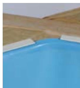
Tense the liner well at the corners Tense bien el liner en las esquinas Tendez bien le liner dans les angles
