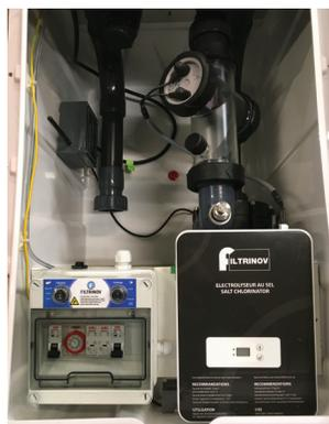
• Il bypass è costituito da una valvola a 3 vie e da un raccordo a T di bypass.
