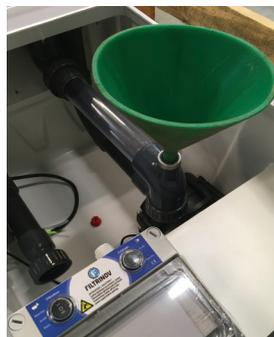
Si raccomanda vivamente di svitare e rimuovere il tappo di scarico del serbatoio subito dopo l'installazione del gruppo di filtrazione.
